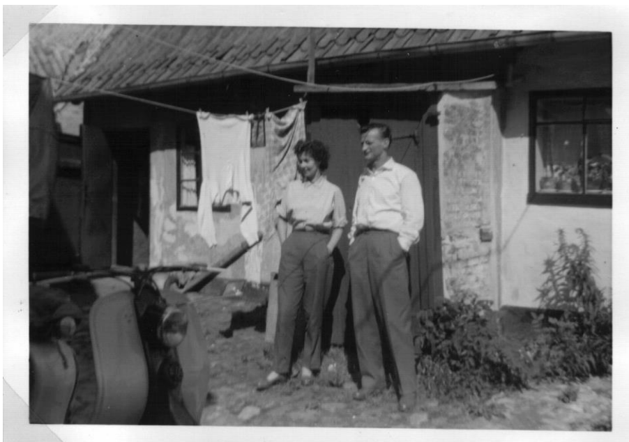
Arbejderlejligheden på Holbæk Museum ca. 50'erne og i dag Foto: Museum Vestsjælland
